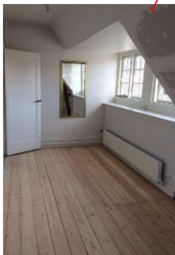
Nyt gips på vægge og loft
